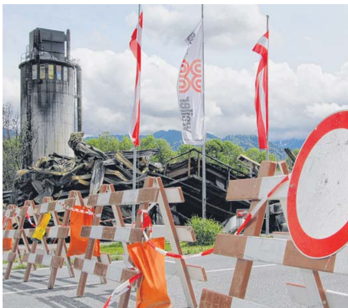
Spurensuche in Weiler-Brandruine Versicherung deckt Ausfall /B1, D1
